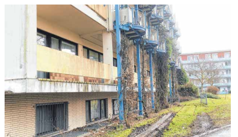
Nicht nur die Fassade des in die Jahre gekommenen Bauteils C der Rehaklinik Maxilianbad in Bad Waldsee hat eine Verschönerung notwendig – auch das Dach wird heuer noch saniert und aktuell werden die Arztzimmer im Gebäude modernisiert. FOTO: SABINE ZIEGLER
