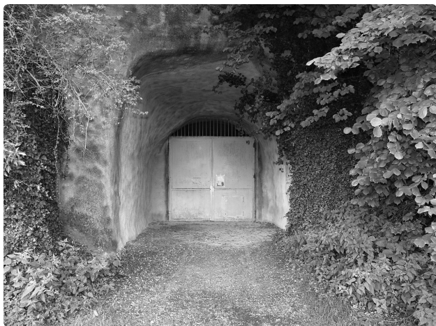
Stolleneingang Goldbacher Stollen
