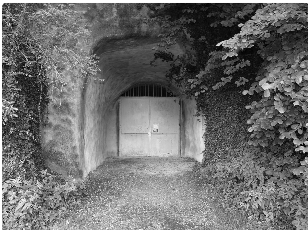
Stolleneingang Goldbacher Stollen
